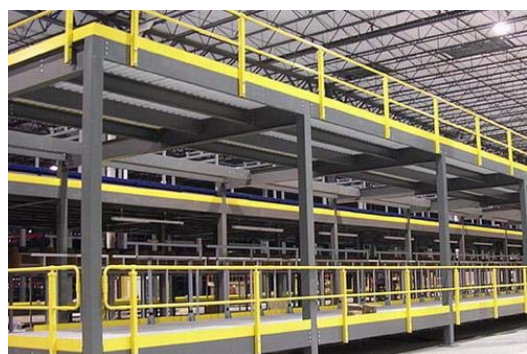
作業架台・安全柵
